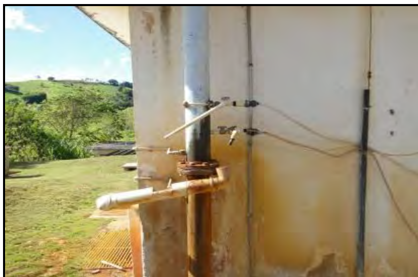
Figura 36 - Aplicação de sulfato de alumínio
