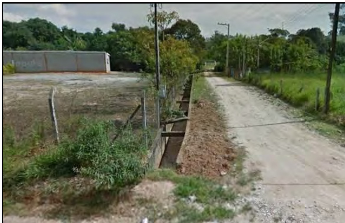
Figura 78 - Vista um canal de drenagem localizado na margem esquerda do Rio do Pinhal
