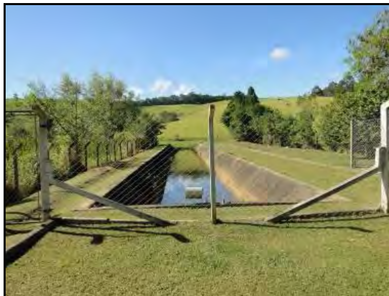
Figura 27 - Captação Rio das Pedras
