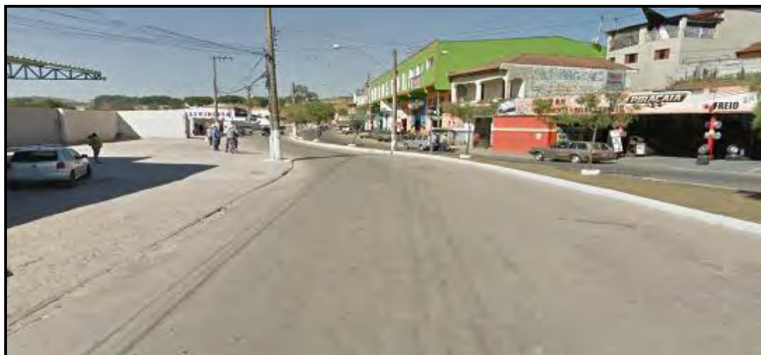
Figura 76 - Vista de outro ângulo da Rua Variante Américo Pedro Benedetti em frente ao Terminal Rodoviário de Pinhalzinho. Onde sofre com alagamentos
