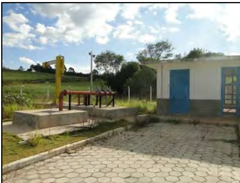
Figura 58 - Estação Elevatória de Esgoto Alto do Pinhal
