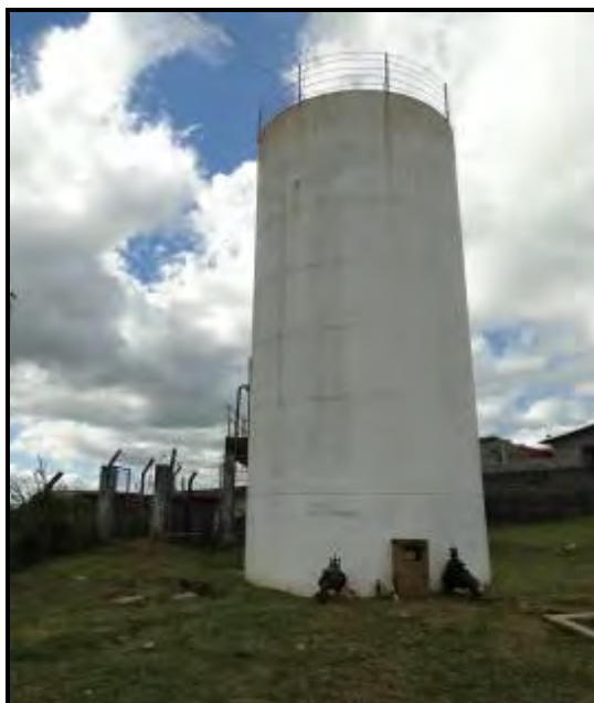
Figura 39 - Sistema de Reservação – Reservatório R2 – 100 m 3
