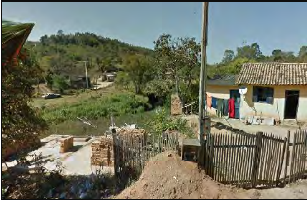
Figura 86 - Vista da área denominada AR-2 (Área de Risco)
