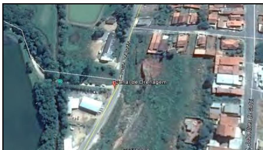
Figura 77 - Vista um canal de drenagem localizado na margem esquerda do Rio do Pinhal
