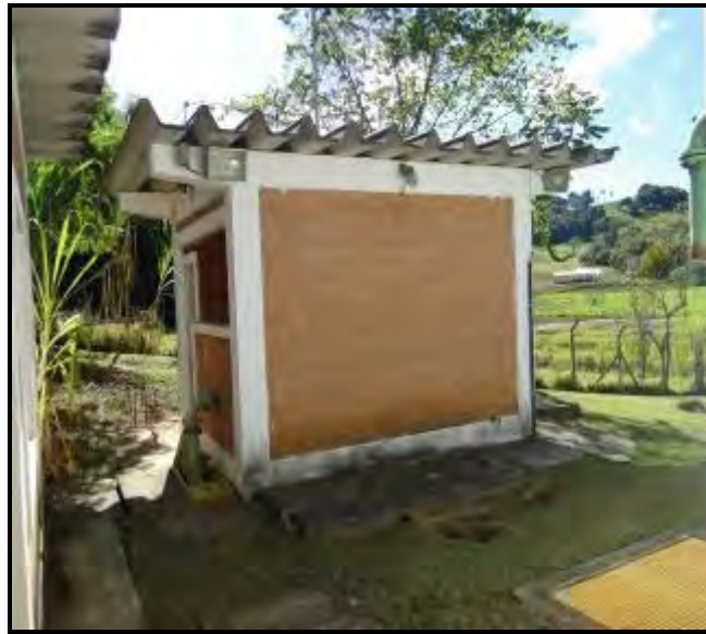
Figura 41 - Estação elevatória de água tratada - ETA
