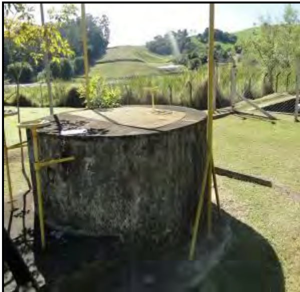
Figura 40 - Estação elevatória de água bruta
