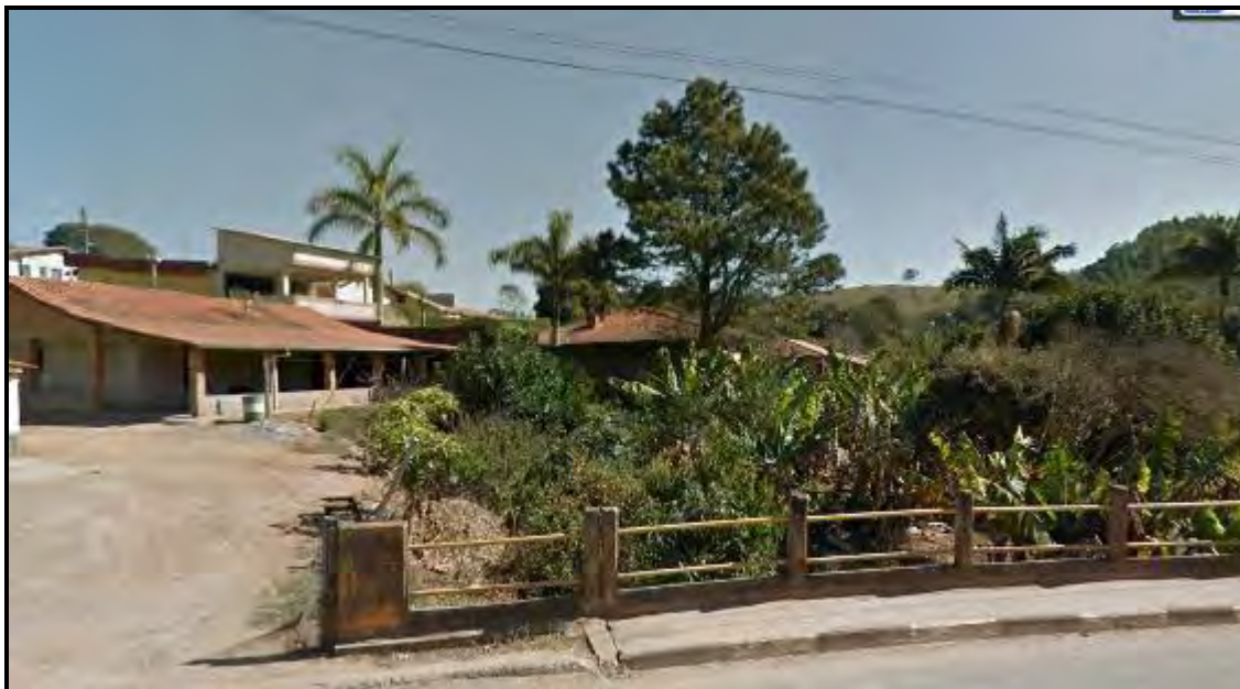
Figura 87 - Vista da área denominada AR-2 (Área de Risco)
